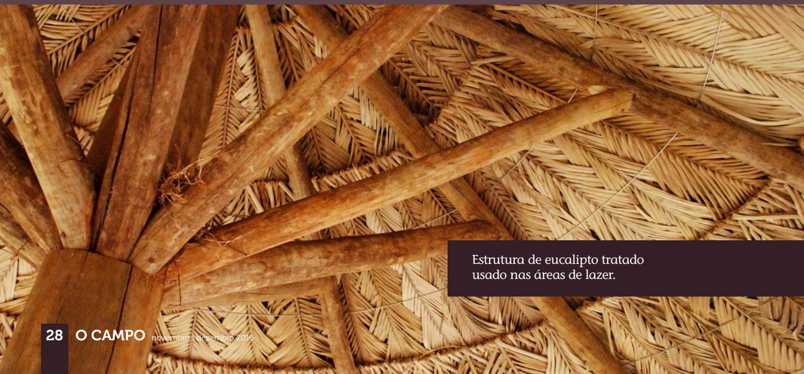
Estrutura de eucalipto tratado usado nas áreas de lazer.
